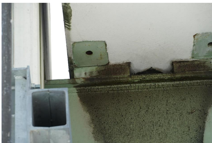
Slika 185: 050239d-241 - Elastomerna ležišča
