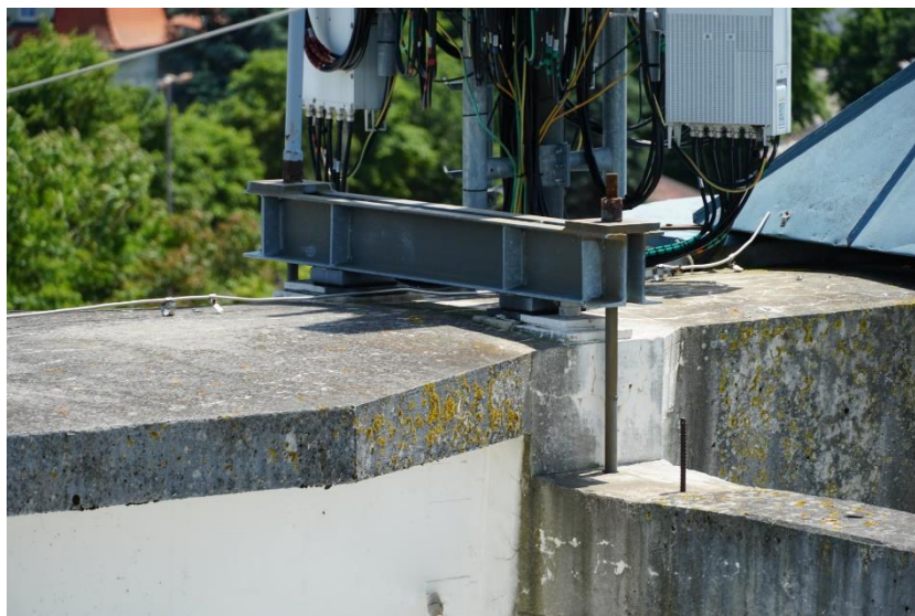
Slika 165: 050239d-189 - Poškodbe nosilcev
