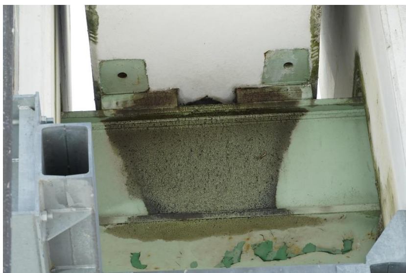
Slika 184: 050239d-240 - Elastomerna ležišča
