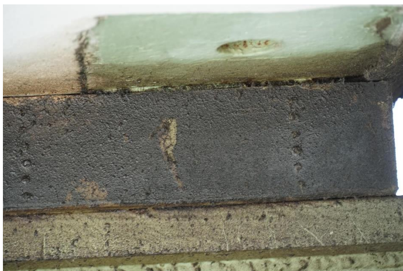
Slika 136: 050239d-155 - Elastomerna ležišča
