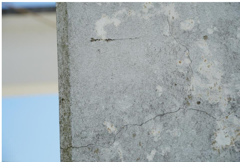
Slika 126: 050239d-140 - Poškodbe nosilcev
