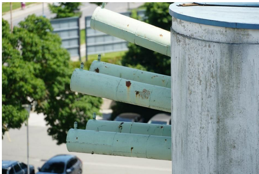
Slika 114: 050239d-196 - Zatege in sidrišča
