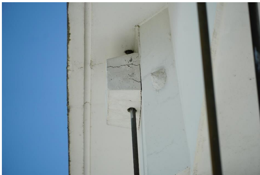
Slika 105: 050239d-111 - Zatege in sidrišča
