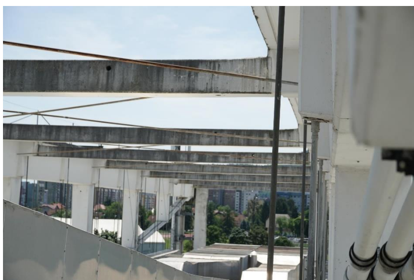
Slika 113: 050239d-159 - Zatege in sidrišča
