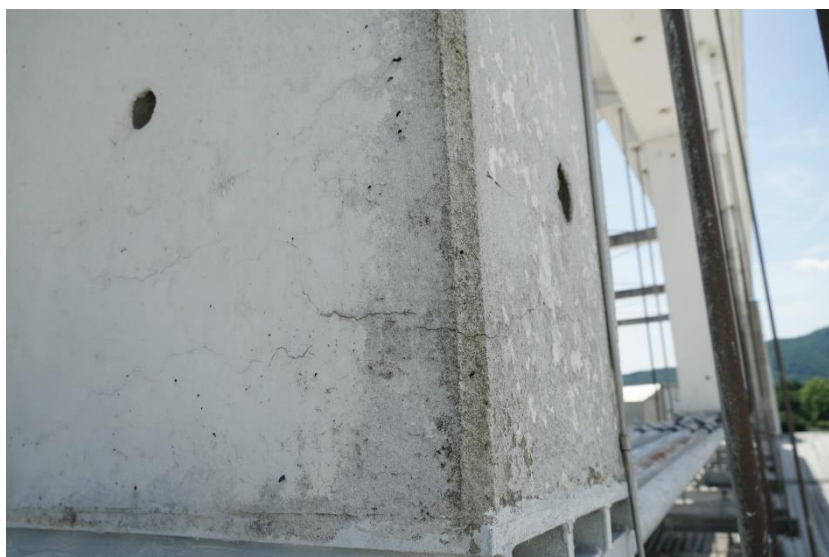
Slika 127: 050239d-141 - Poškodbe nosilcev
