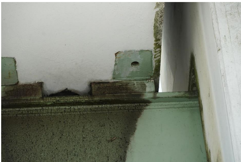
Slika 186: 050239d-242 - Elastomerna ležišča
