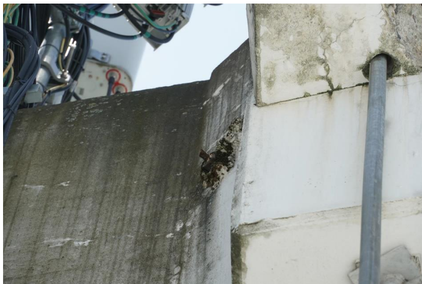
Slika 123: 050239d-247 - Zatege in sidrišča
