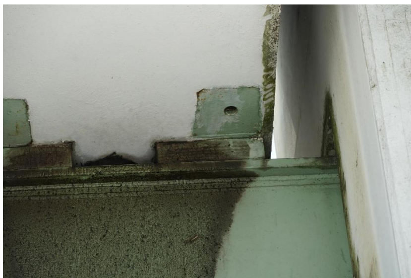
Slika 141: 050239d-242 - Elastomerna ležišča
