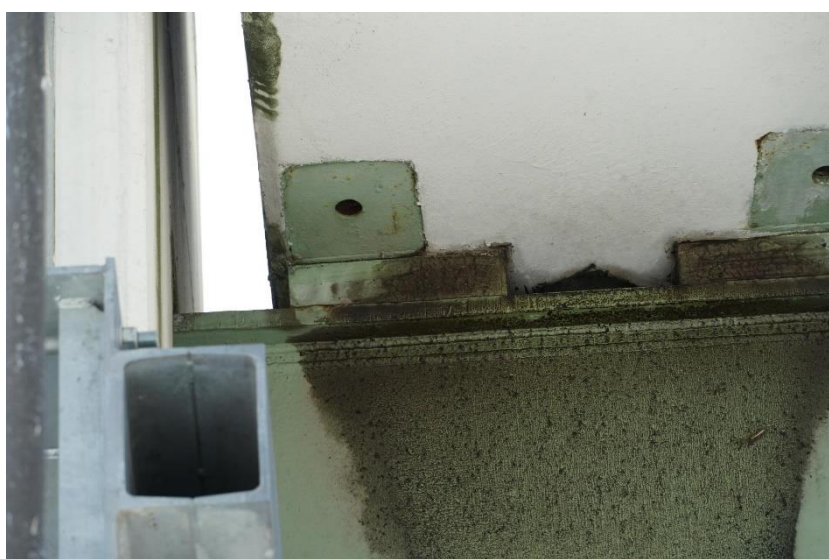
Slika 140: 050239d-241 - Elastomerna ležišča
