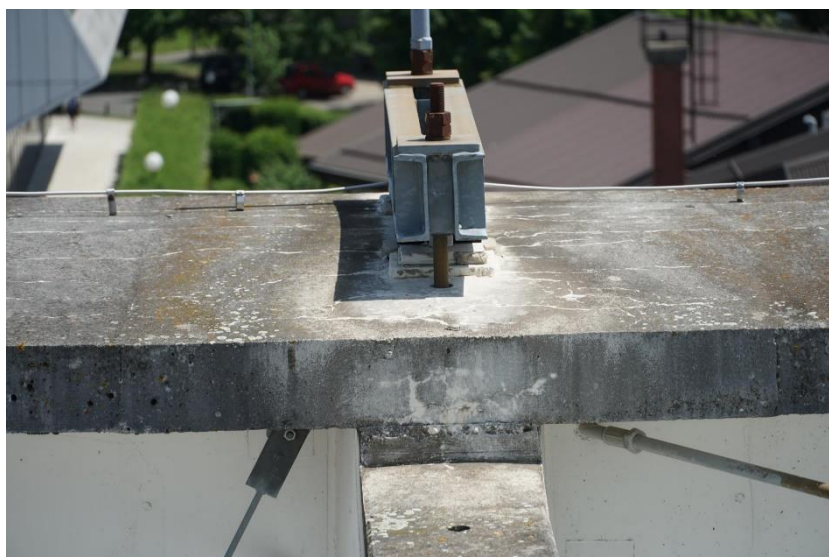
Slika 163: 050239d-187 - Poškodbe nosilcev
