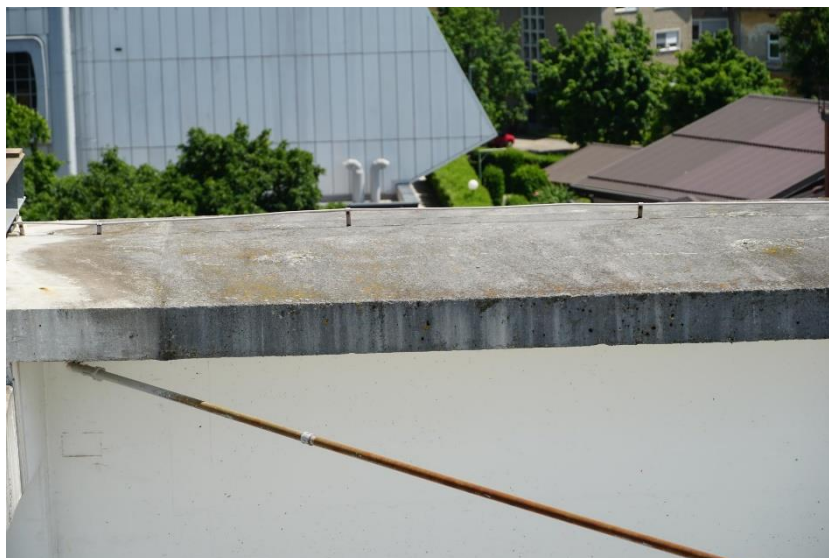
Slika 171: 050239d-195 - Poškodbe nosilcev
