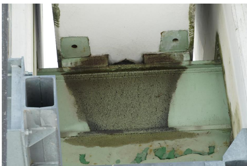
Slika 139: 050239d-240 - Elastomerna ležišča
