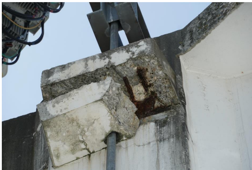
Slika 120: 050239d-243 - Zatege in sidrišča
