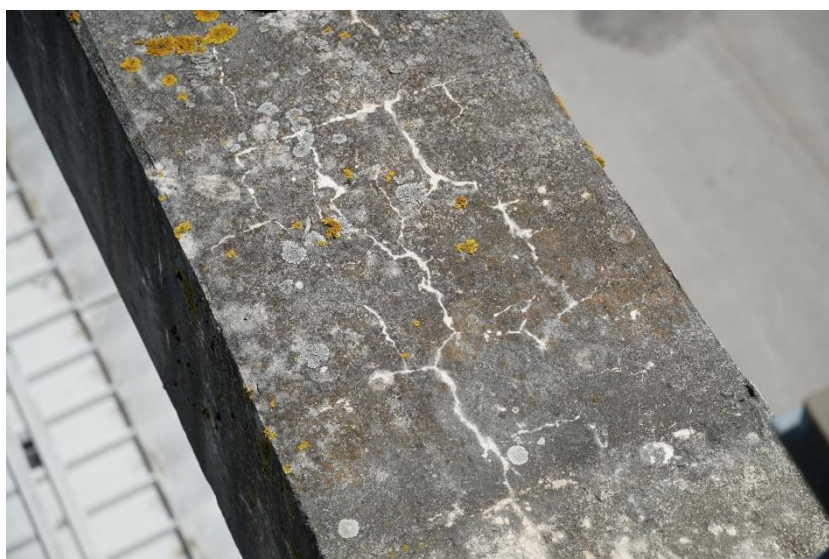
Slika 161: 050239d-185 - Poškodbe nosilcev
