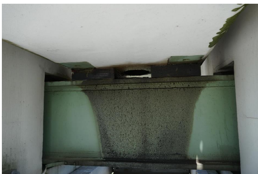
Slika 134: 050239d-153 - Elastomerna ležišča
