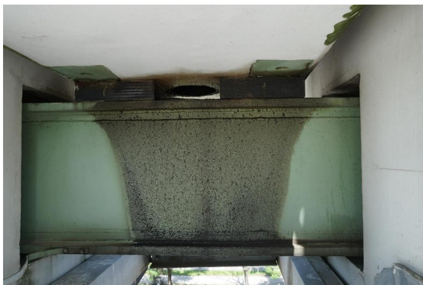
Slika 183: 050239d-157 - Elastomerna ležišča
