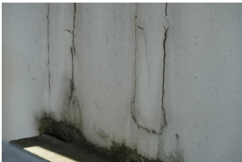
Slika 175: 050239d-202 - Poškodbe nosilcev
