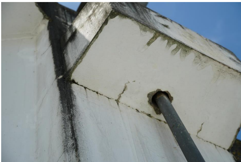
Slika 117: 050239d-215 - Zatege in sidrišča
