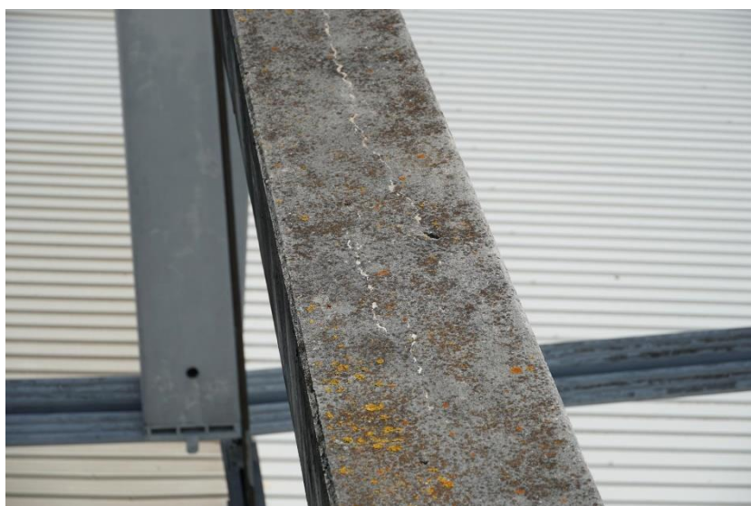
Slika 152: 050239d-176 - Poškodbe nosilcev
