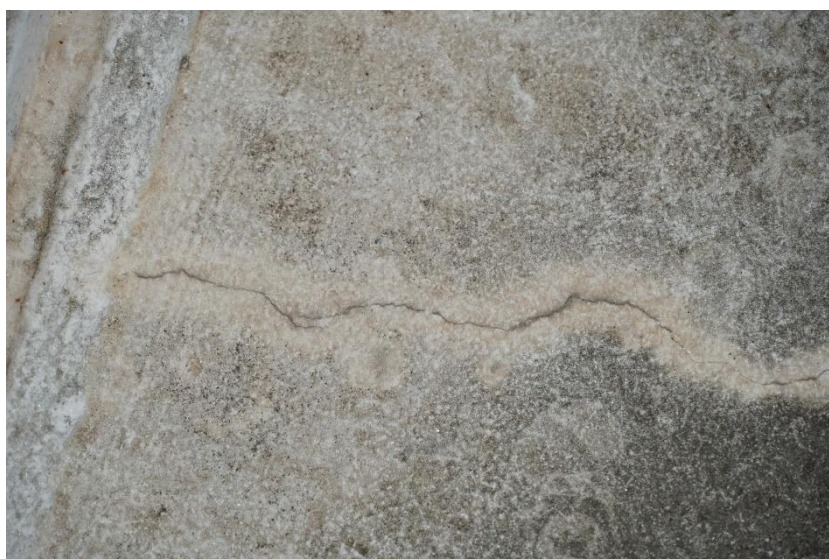
Slika 155: 050239d-179 - Poškodbe nosilcev
