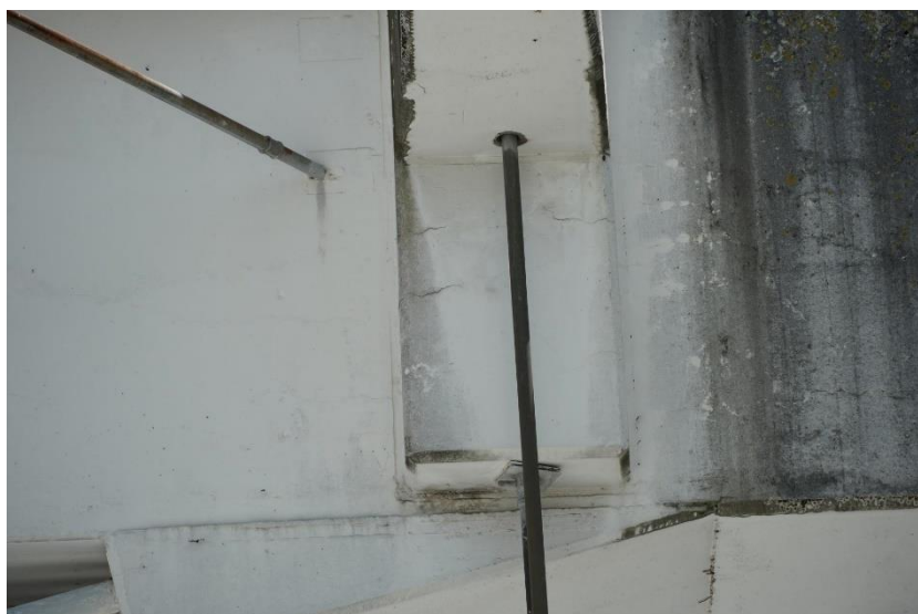
Slika 103: 050239d-107 - Zatege in sidrišča
