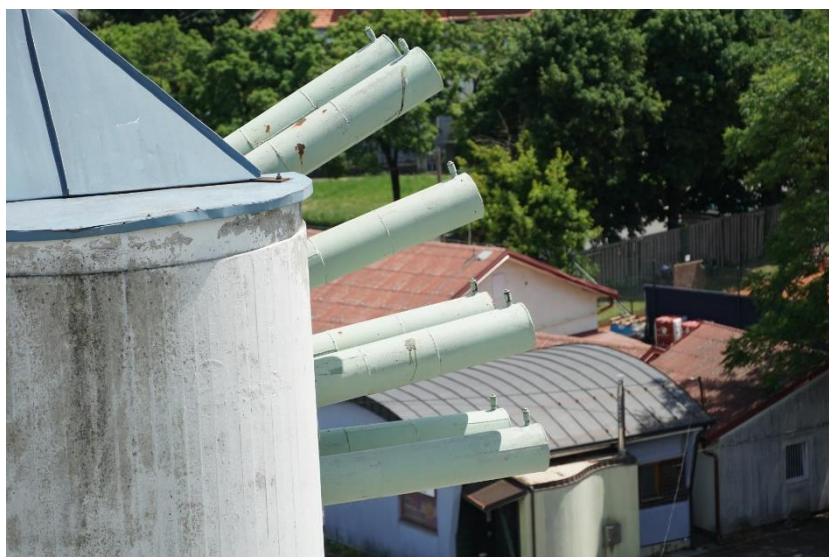
Slika 160: 050239d-184 - Poškodbe nosilcev
