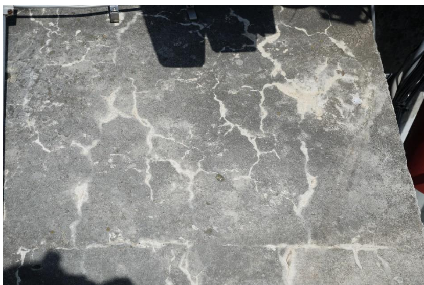
Slika 145: 050239d-169 - Poškodbe nosilcev
