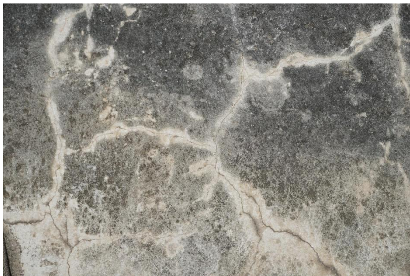
Slika 156: 050239d-180 - Poškodbe nosilcev
