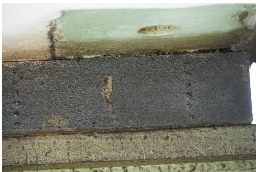
Slika 181: 050239d-155 - Elastomerna ležišča
