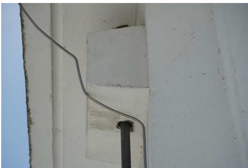
Slika 119: 050239d-218 - Zatege in sidrišča
