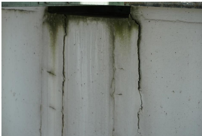
Slika 174: 050239d-201 - Poškodbe nosilcev
