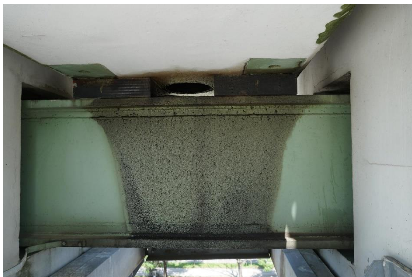
Slika 138: 050239d-157 - Elastomerna ležišča
