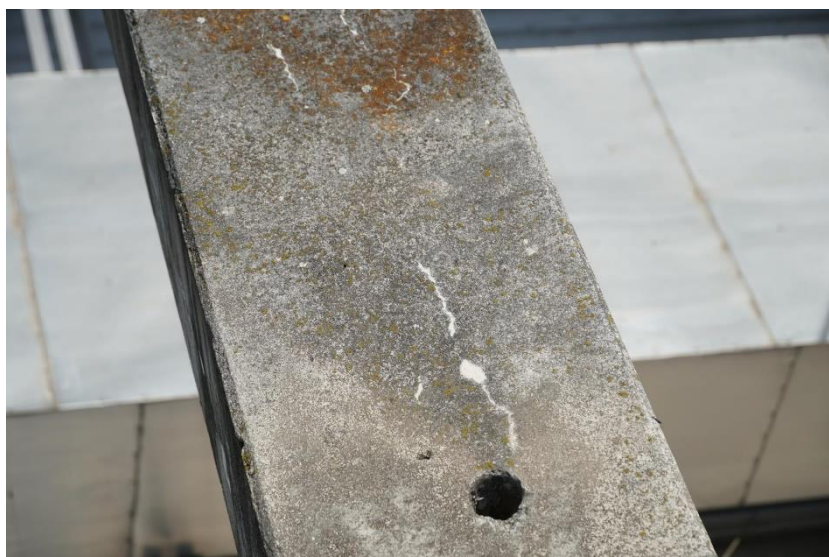
Slika 151: 050239d-175 - Poškodbe nosilcev
