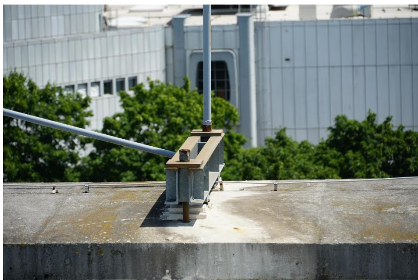
Slika 169: 050239d-193 - Poškodbe nosilcev
