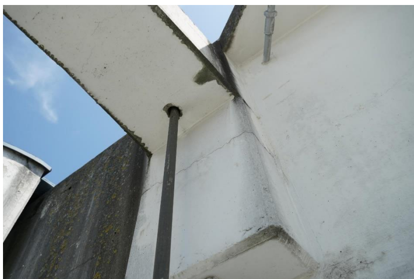
Slika 116: 050239d-203 - Zatege in sidrišča
