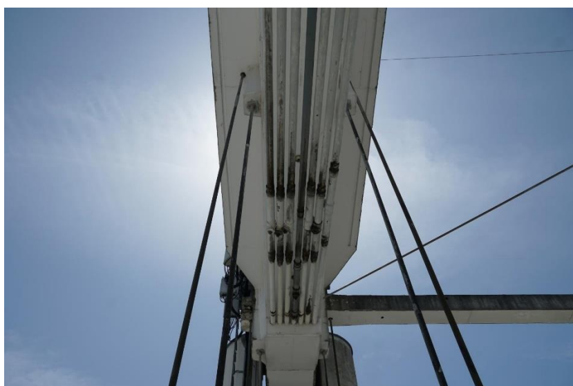
Slika 98: 050239d-236 - Zunanji kabli
