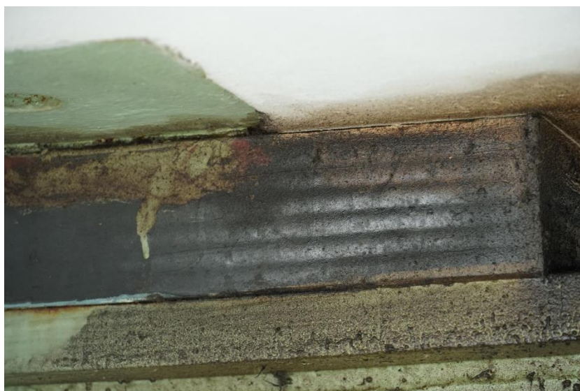
Slika 135: 050239d-154 - Elastomerna ležišča
