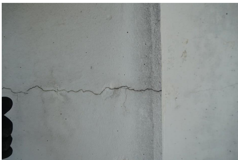
Slika 176: 050239d-204 - Poškodbe nosilcev
