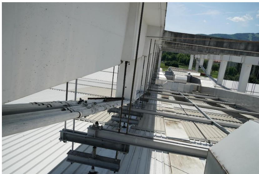
Slika 177: 050239d-205 - Poškodbe nosilcev
