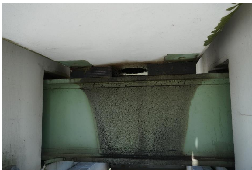
Slika 179: 050239d-153 - Elastomerna ležišča
